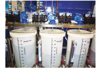
دوزینگ پمپ های تزریق مواد شیمیایی بهسازی اسمز معکوس
