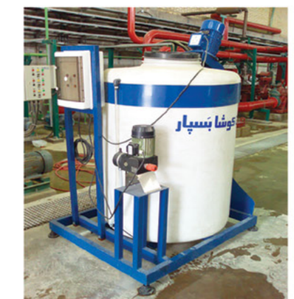
پکیج تزریق مواد شیمیایی و هیدروکلریناتور
