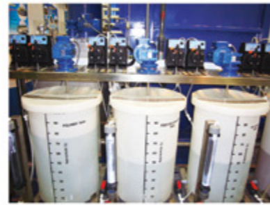
دوزینگ پمپ های تزریق مواد شیمیایی بیسازی اسمز معکوس
