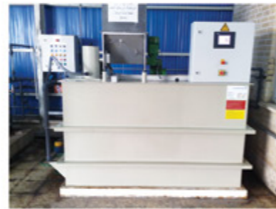
دوزینگ یونیت تهیه و تزریق مواد ملعقد کننده پلیمری - پلی الکترولیت
