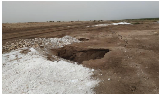
شکل ۷- قیف کشیدگی در مسیر کلکتور
