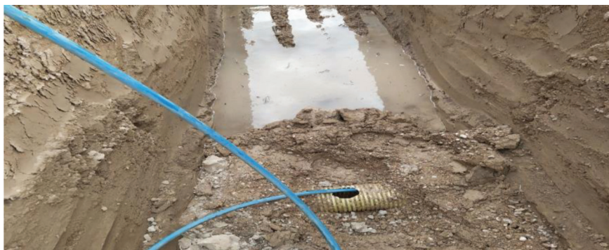
شکل ۴- فلشینگ جت لترال از وسط مزرعه
