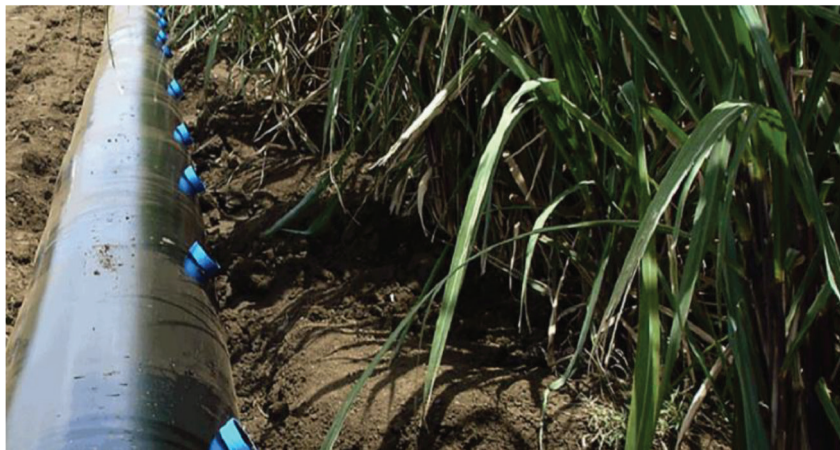
شکل ۱ - نمونه لوله آبیاری هیدروفلوم کارگزاری شده در مزارع نیشکر
