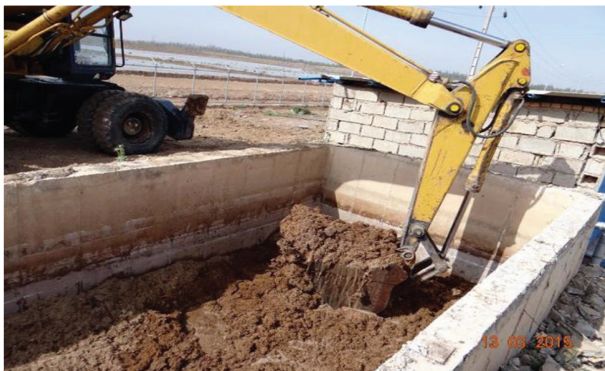
شکل ۷- نمونه پایلوت استخر تهیه شده برای خیساندن اولیه سرشاخه یا باگاس
