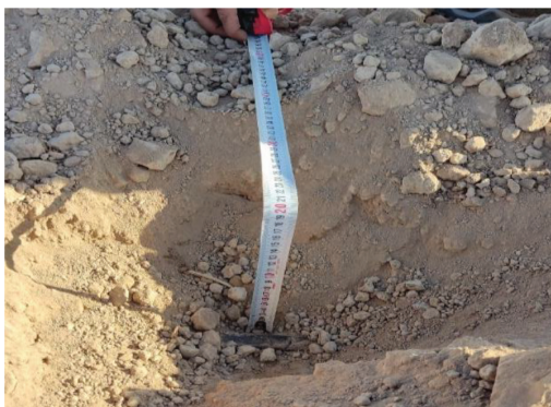
شکل ۱- لوله‌گذاری با استفاده از دستگاه لوله‌گذار آبیاری قطره‌ای زیرسطحی و کنترل عمق کارگذاری لوله
